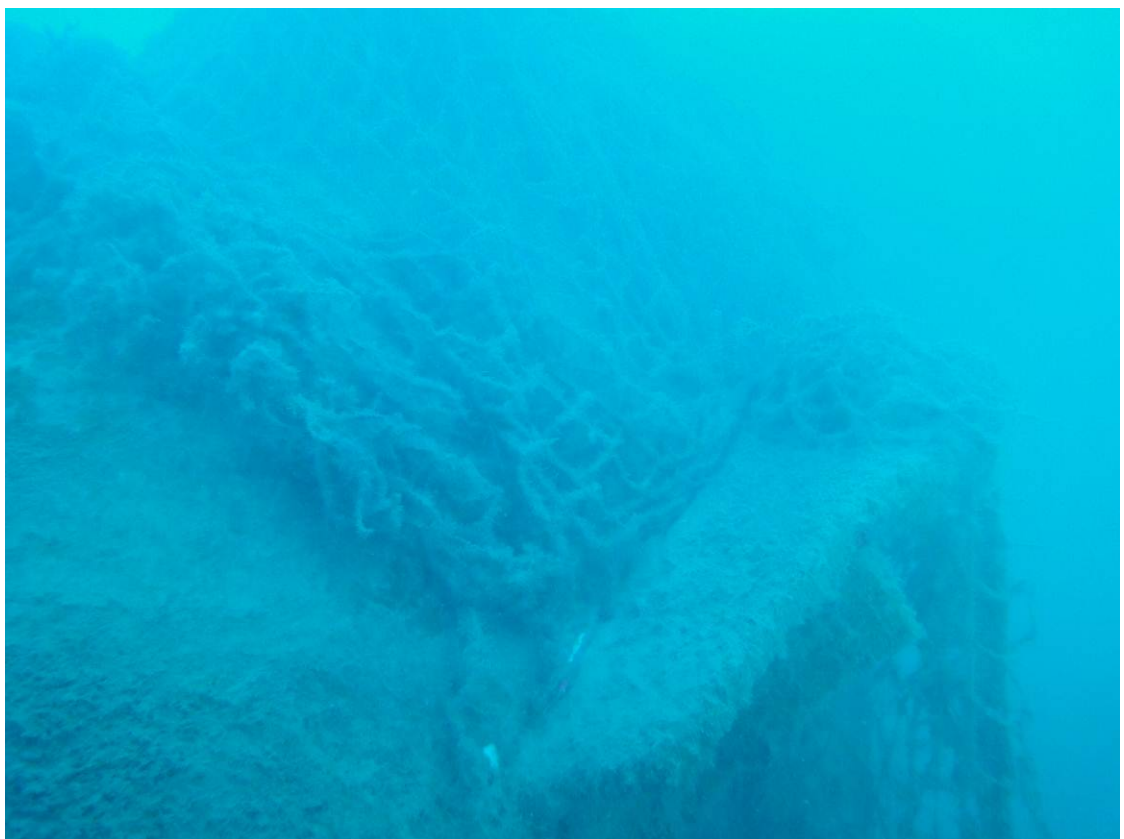
Photo 14 : Partie non ensouillée de l'émissaire au niveau du coude autour de 15m de profondeur
