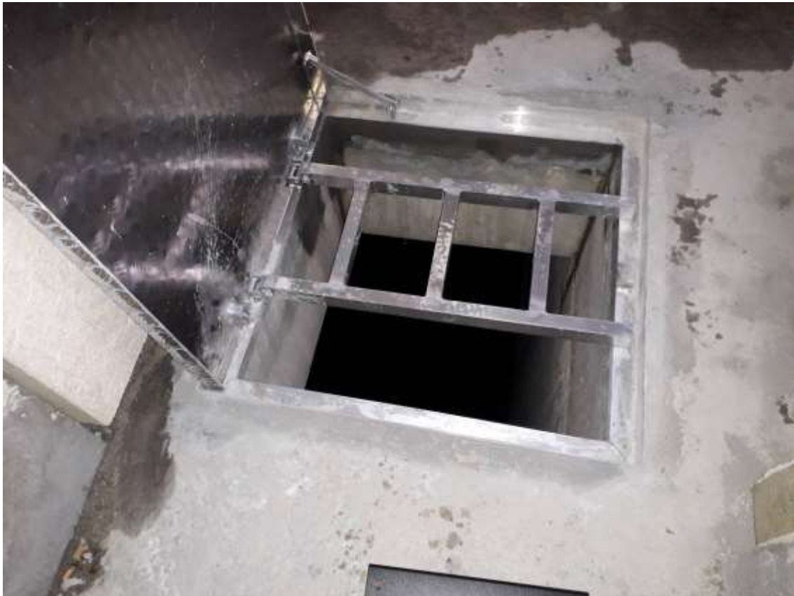
Regard d'accès cuve de fioul et intérieur du local
