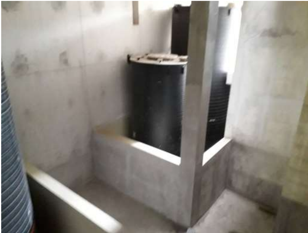
Cuves de stockage des produits chimiques
