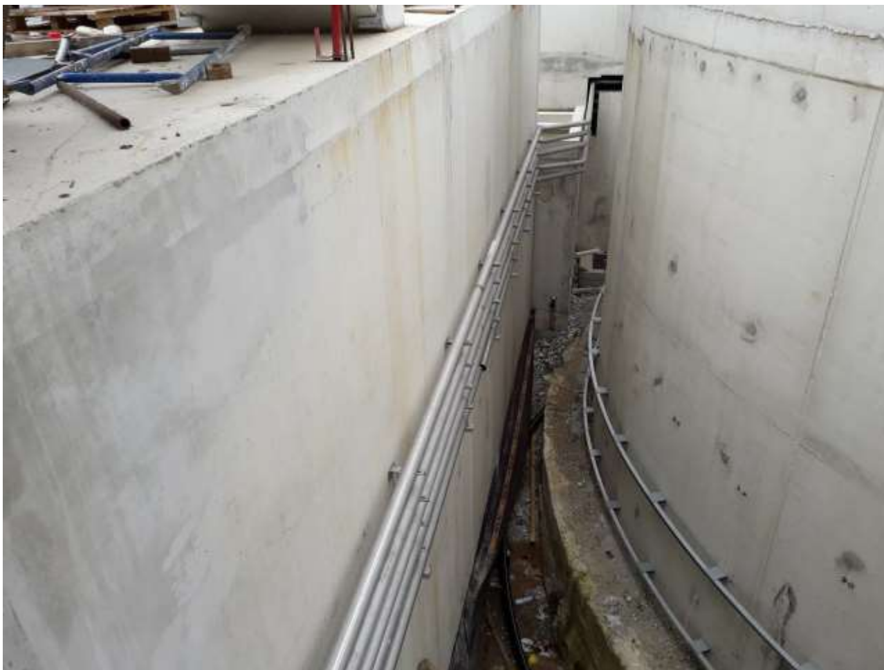
Vue extérieure de la bâche d'homogénéisation (à gauche) et d'un digesteur (à droite)
